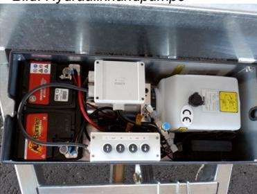
Bild: Steuereinheit Elektrohydraulik
